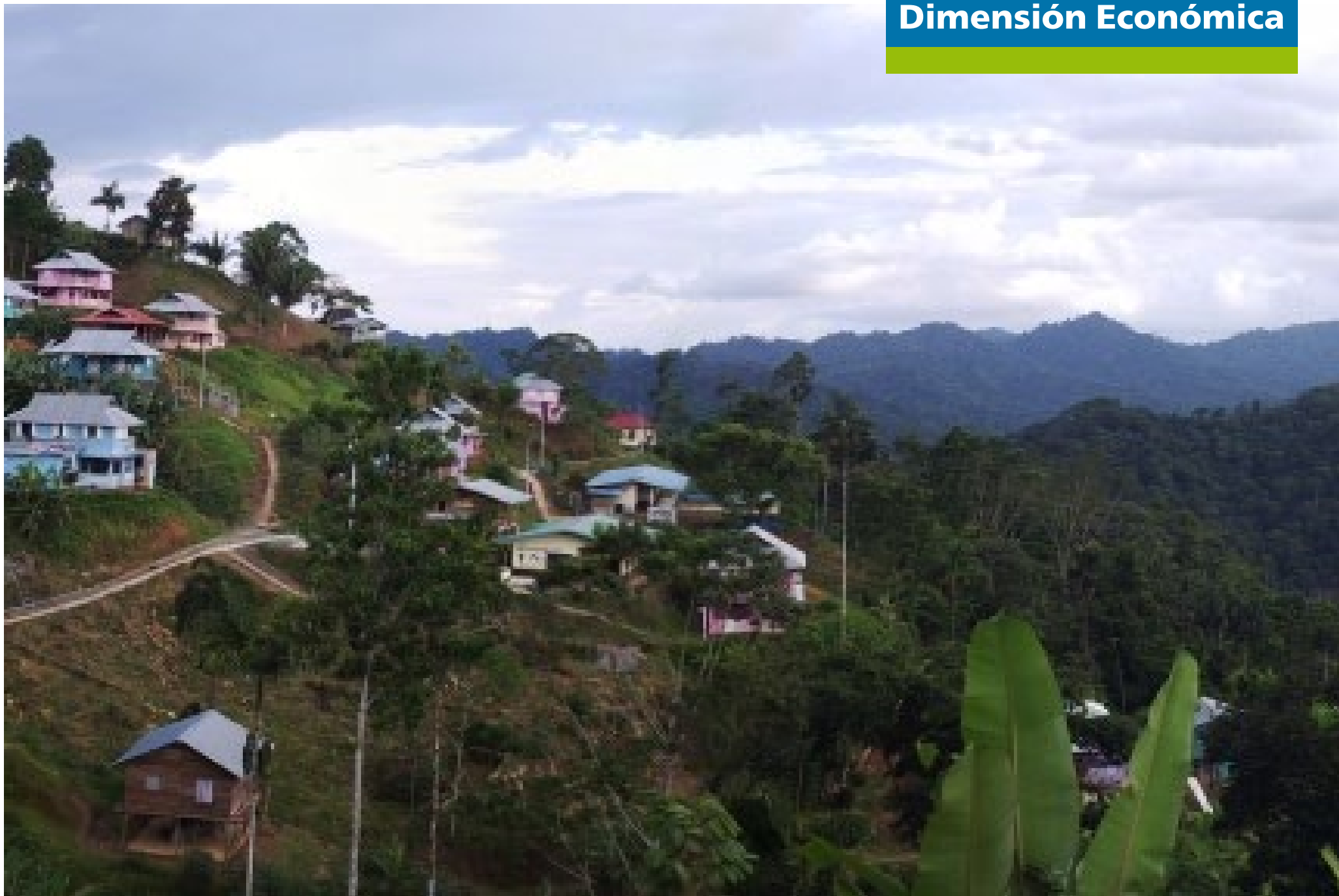
Proyecto de electrificación rural de las comunidades circunvecinas a la Central Changuinola I
